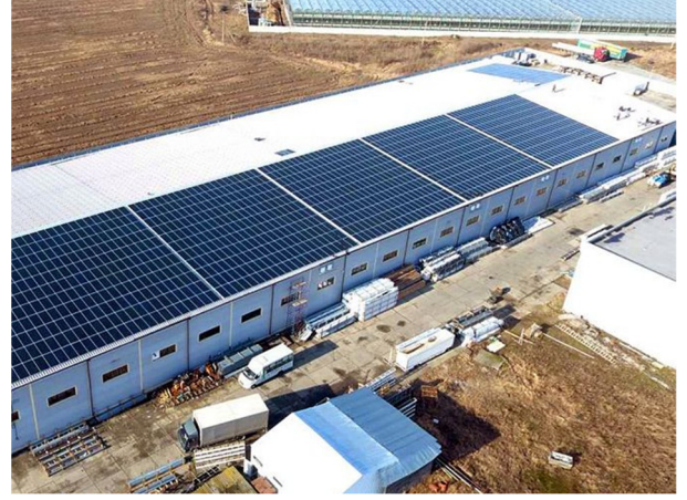
Fabrika Çatısı GES Uygulamaları
